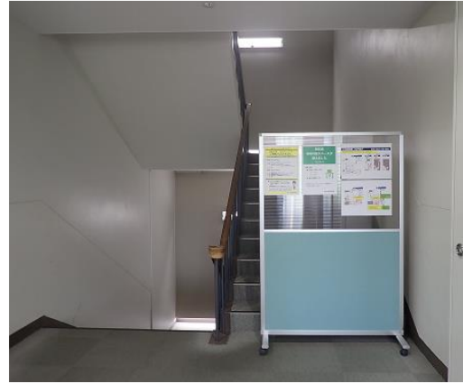
本館 2F 階段 (本館 3F に通行不可)
